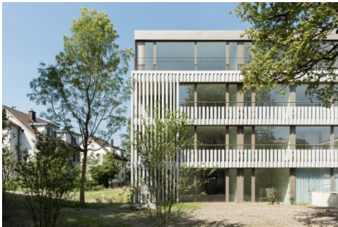
Abb. A. 8: Neubau MFH 2SOL
