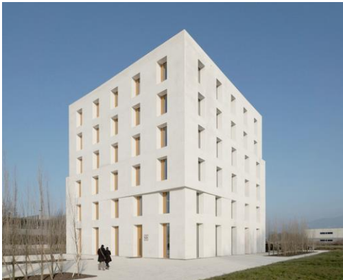
Abb. A. 3: Bürogebäude 2226
