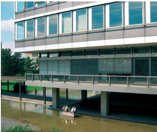
Abb. A. 7: HPZ Zentralgebäude
